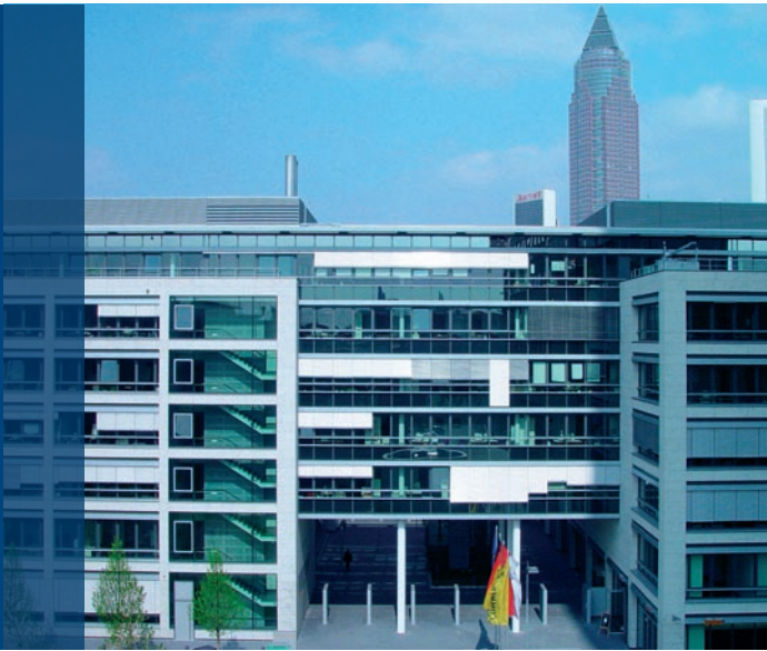
Dienstleistungszentrum der Commerzbank AG in Frankfurt am Main
